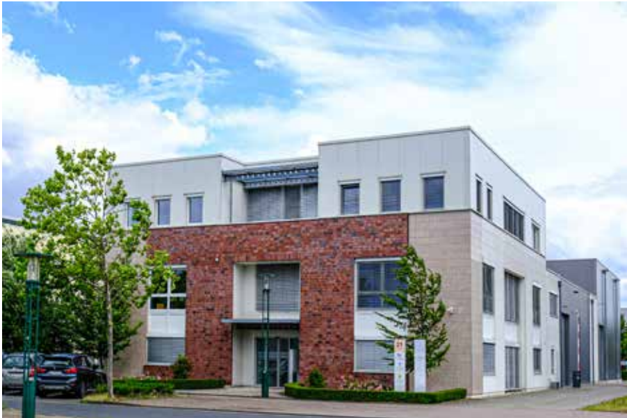
Firmensitz im Stahlwerk Becker in Willich
