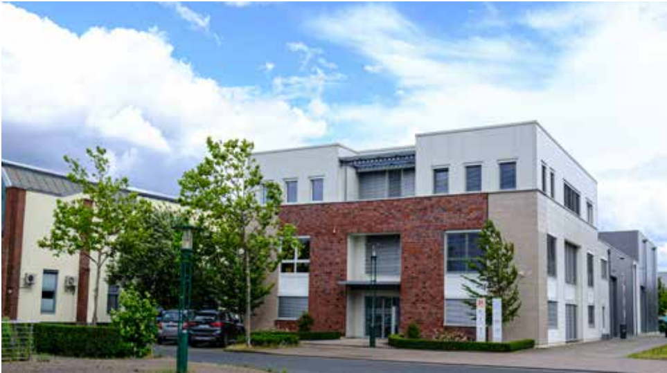
Firmensitz im Stahlwerk Becker in Willich
