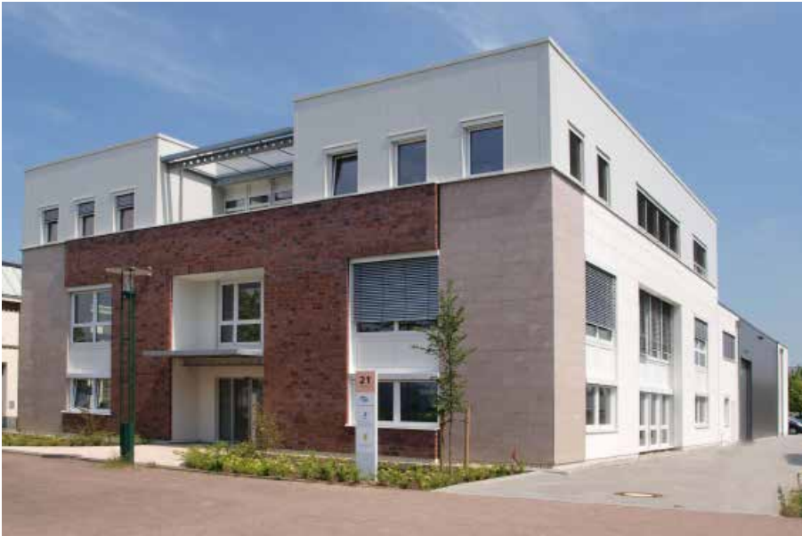
Firmensitz im Stahlwerk Becker in Willich
